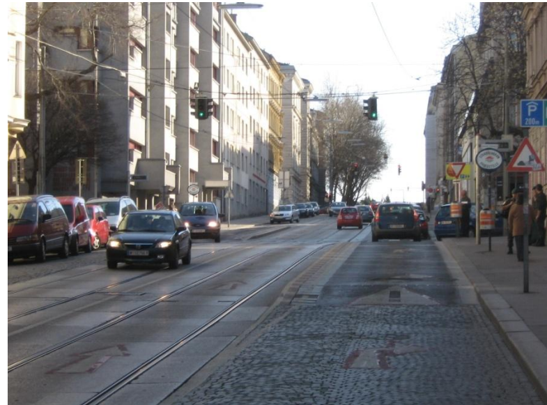
Panikengasse (Linie 9) mit überfahrbarem Haltestellen-Kap (Hst. Koppstraße).
