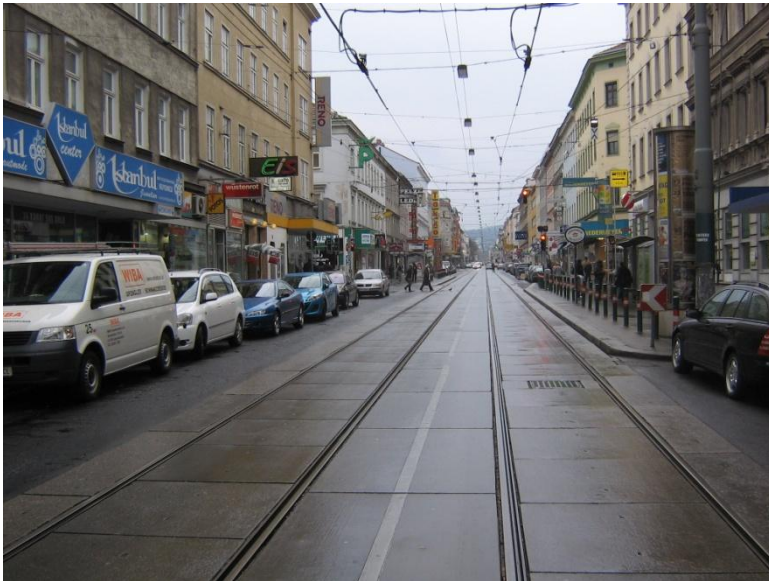
Thaliastraße (Linie 46) mit vorgezogenem Haltestellen-Kap (Hst. Brunnengasse).
