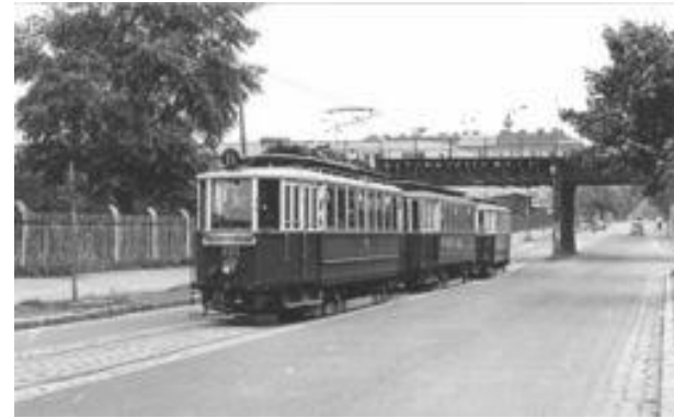
S-Bahnbrücke (heute Hst. Handelskai) mit 11er (Typ H 1 ) Richtung Fr.-Engels-Platz.
